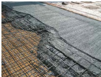
Мал. 30.10. Заливання арматурного каркасу бетоном
