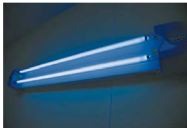
Мал. 19.4. Кварцову лампу використовують для дезінфекції приміщень. Ця лампа — джерело ультрафіолету, під дією якого в повітрі утворюється озон, що вбиває бактерії. Слід пам'ятати, що ультрафіолетове світло від цієї лампи шкідливе для очей!
