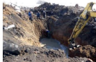
Іл. 33.11. Викотування водовідвідної каналу
