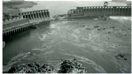
Іл. 32.7. Зруйнована вибухом гребля Дніпрогесу в 1941 р.
