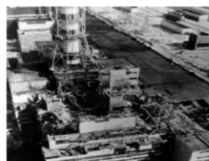
Іл. 32.14. Аварія на Чорнобильській АЕС
